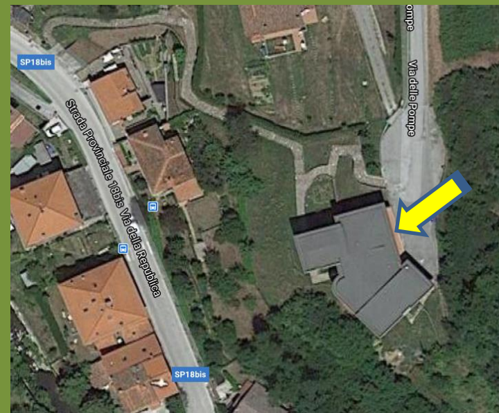
Ingresso porta piano principale Classi 2-3
